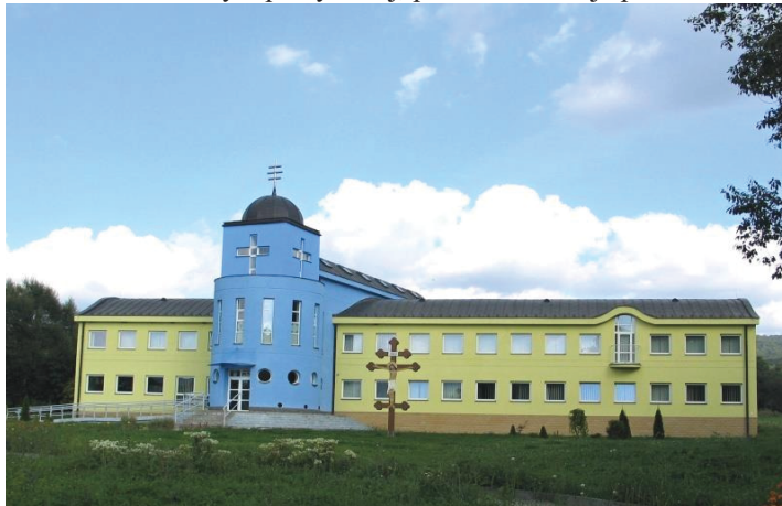
Obr. 1 Pohľad na budovu Monastyru Krásny Brod
