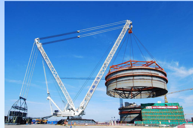
Stavba reaktorovej nádoby a ochranného obalu, JE Haiyang, Čína
