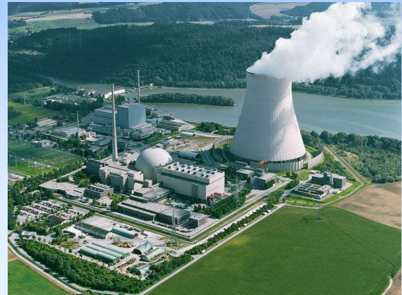
JE Kernkraftwerk Isar Block 2, Nemecko
