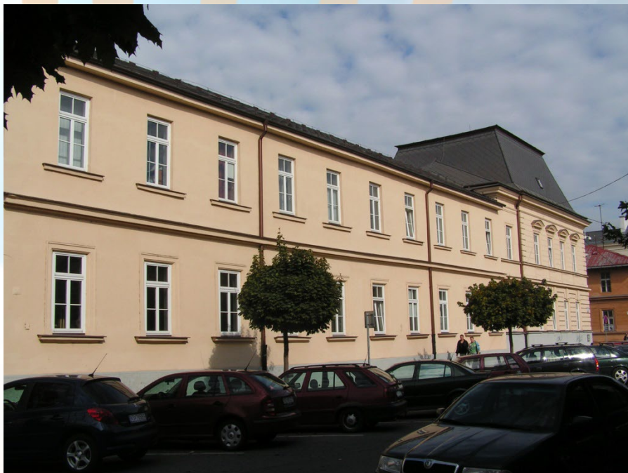
Sídlo katedry po rekonštrukcii – pohľad zo Zbrojničnej ulice
