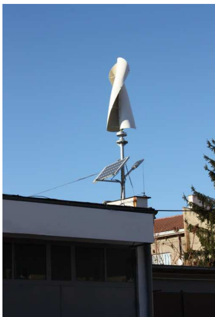
Obr. 18 Hybridná slnečno-veterná elektráreň
